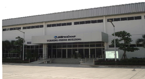
อาคารประหยัดพลังงานของโรงงานใหม่
